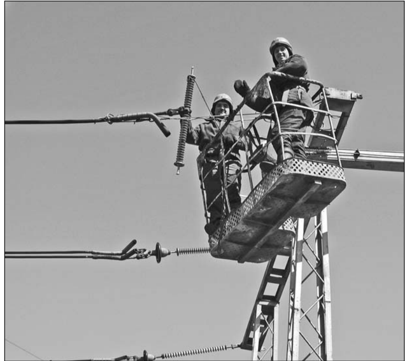
Монтаж новой ЛЭП
