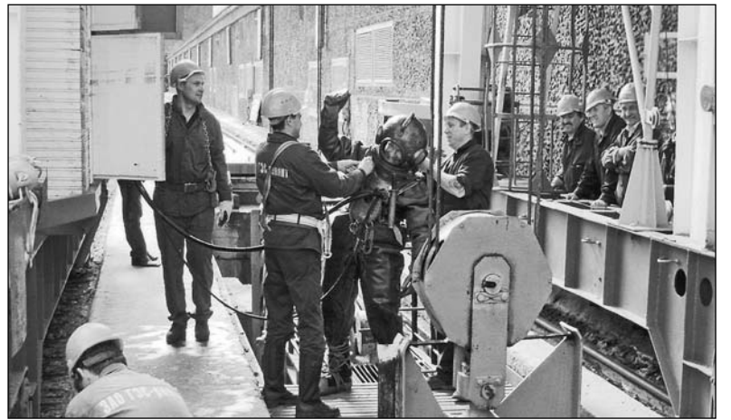
бригада ЗАО ГЭС—ремонт за работой
